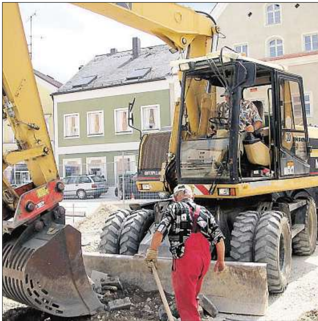
Bagger und andere Baufahrzeuge bestimmen seit Monaten das Bild der Innenstadt in Dietfurt. Unter Hochdruck wird dort gearbeitet. Geplant ist, im September mit dem ersten Bauabschnitt fertig zu sein.
